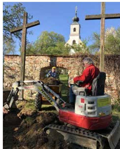
Zuletzt wurde am Platz vor der Kreuzigungsgruppe Erde ausgehoben und Schotter aufgebracht, um schließlich auf dem Boden Platten zu verlegen. Die Mauern um den Platz wurden gereinigt und die Kreuze für eine sorgfältige Restaurierung abmontiert. Der Bauhof der Stadtgemeinde hat den Zugang zu einigen Stationen saniert.
